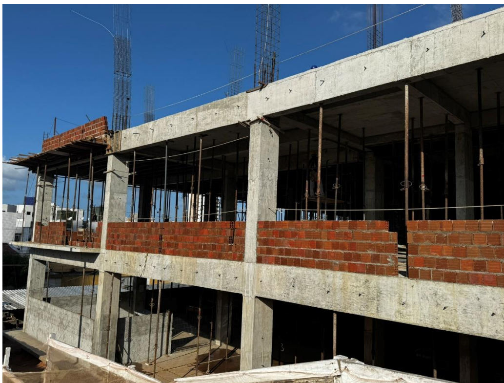
Figura 9. Elevação de alvenaria no primeiro semienterrado.
