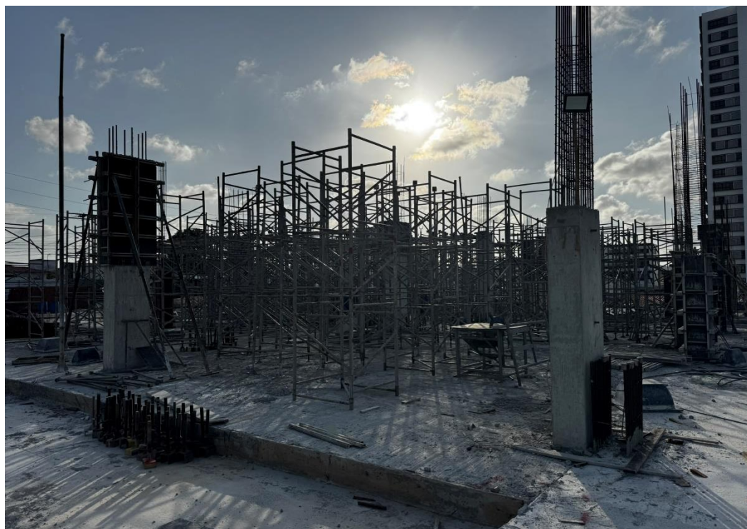
Figura 7. Montagem e concretagem dos pilares do térreo.
