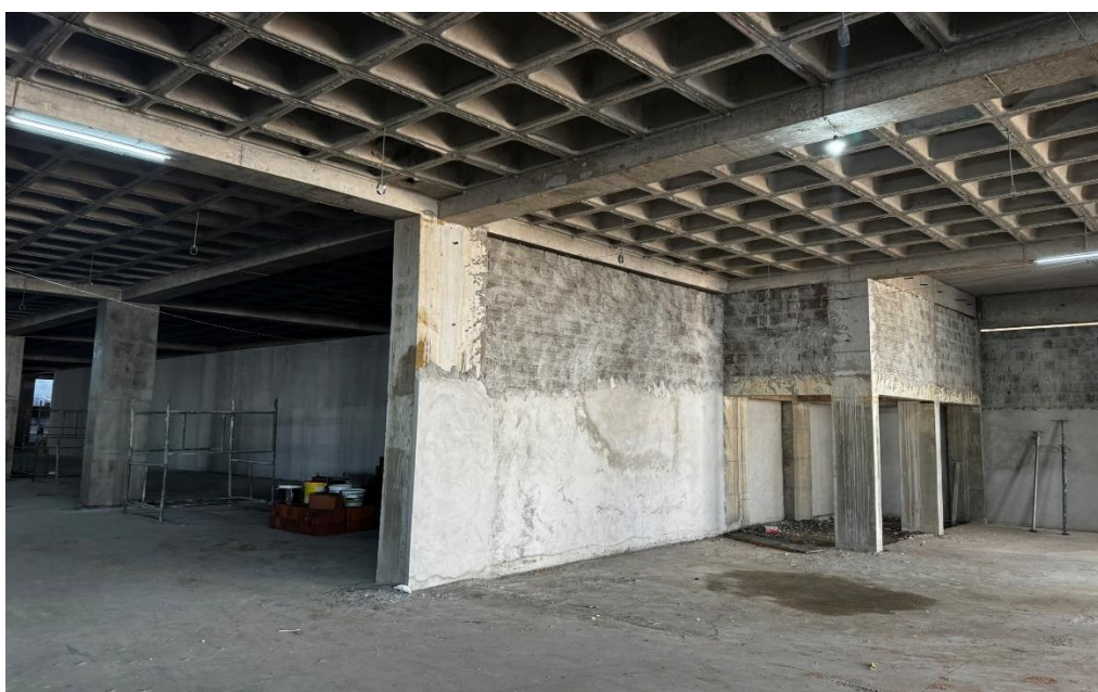
Figura 10. Execução de chapisco e reboco em alvenaria do segundo subsolo.
