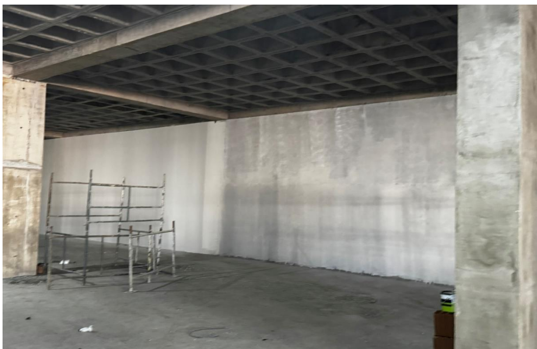
Figura 11. Parede com Reboco em finalizado no segundo semienterrado.
